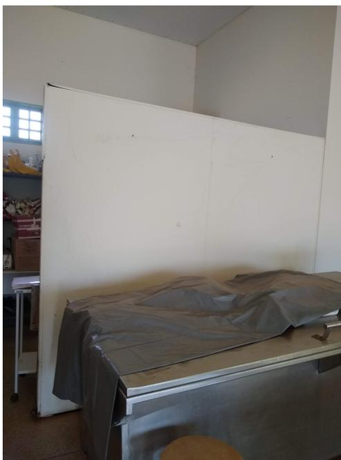
Figura 13 - Divisórias a serem retiradas e substituídas por gesso acartonado.
